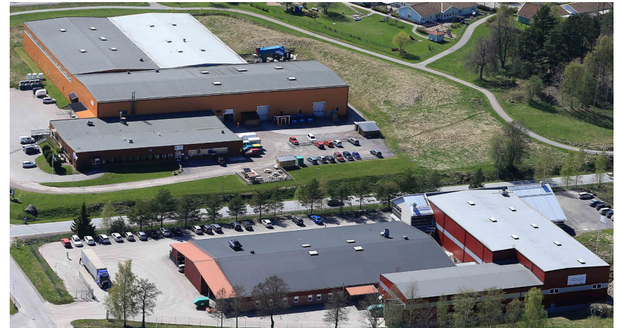
ABIGO:s produktionsläggning i Askersund efter senaste utbyggnaden och nyligen inköpt byggnad för ytterligare expansion.
